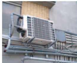
温泉/冷風 + 温水によるボイラー給水加熱
